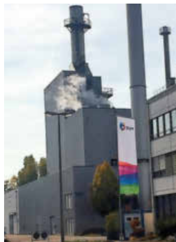
Das neue Dampfturbinenkraftwerk von DSM in Grenzach.
