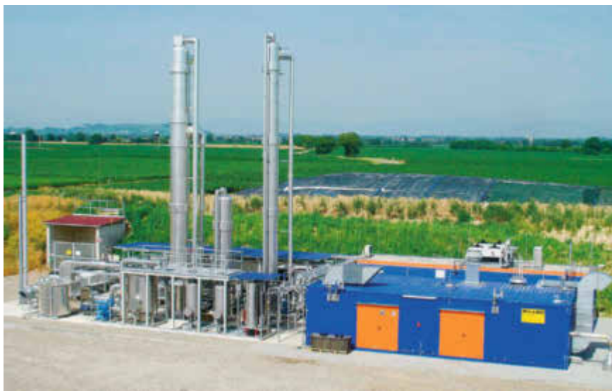
Bioerdgasaufbereitungsanlage in Forchheim
