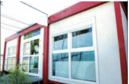
Die Anlage hat 2-fach Isolierverglasung (mit Rolläden) und Zusatzisolierung auf dem Dach (mit Brandschutz- Beton- Oberfläche). Die Anlage wurde als Büroanlage mit Ladenfläche genutzt, sie ist mit diversen Steckdosen und Kabelkanälen (EDV/Elektro etc.), für eine individuelle und flexible Nutzung ausgestattet.
