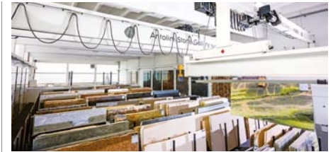
Freitragende Konstruktion: Die neue Kranbahn ragt mehr als 3 Meter in den breiteren Hallenteil hinein. Dieser Bereich kann von beiden Kränen bedient werden.
