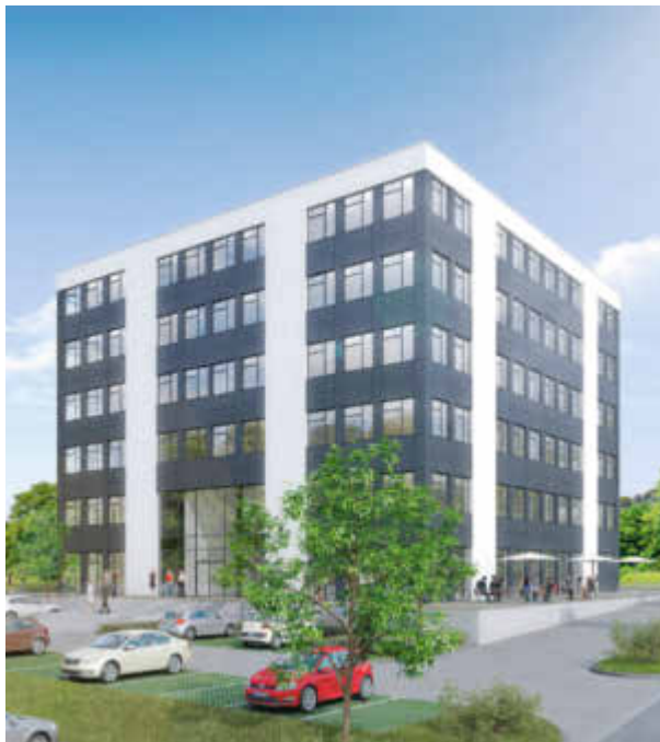
Je 25 Meter hoch, breit und tief ist der „Cube“, den das Ingenieurbüro Sachs derzeit in Engen baut.
