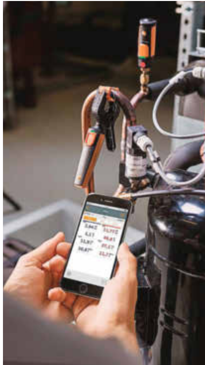
Per Testo-App können Techniker Klima- und Kälteanlagen überprüfen und analysieren. Die Messdaten etwa zu Druck und Temperatur werden via Bluetooth an das Smartphone gefunkt.
